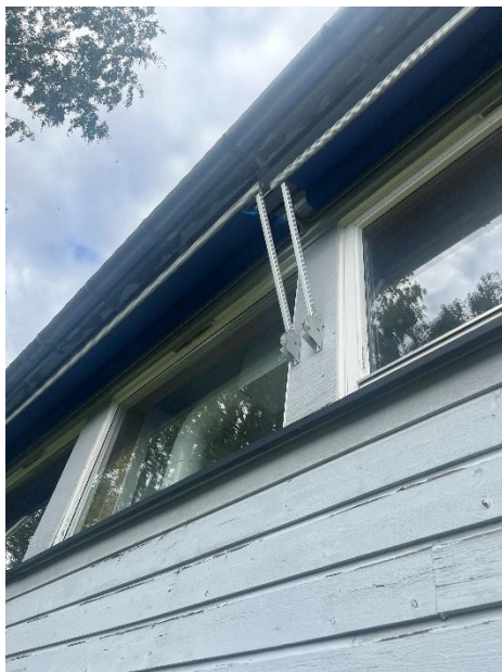
Bilde 17 Utvendig markise.
