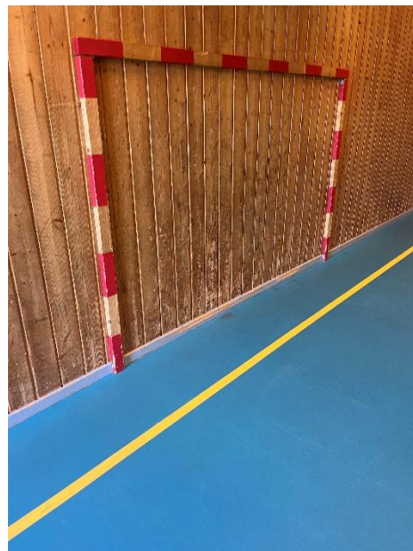
Bilde 18 Slitt panel idrettshall.
