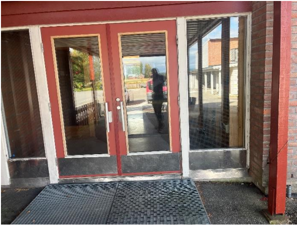
Bilde 13 Ytterdør av tre med glassfelt.
