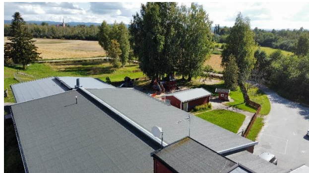
Bilde 30 Oversiktsbilde deler av tak.
