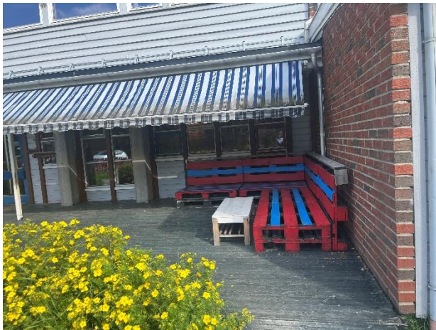
Bilde 15 Markise er skjev og har jordslag.
