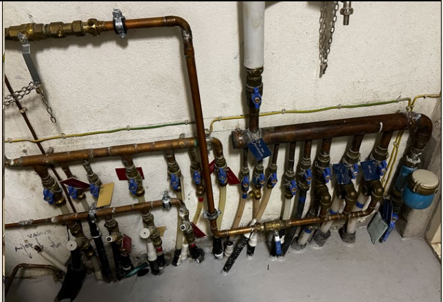
Bilde 6: Hovedvanninnlegg med kulekran. Fordeling av kaldt- og varmtvann, uten isolasjon.
