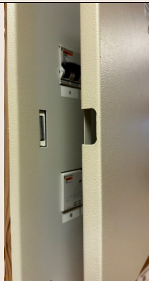
Bilde 4: Underfordeling i avdeling (1 av 3). Defekt magnetlås på skap, men skap sitter i god høyde.
