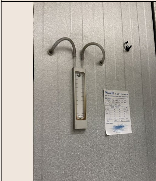
Bilde 11: Defekt differansetrykkgiver over filter på vent. aggregat.
