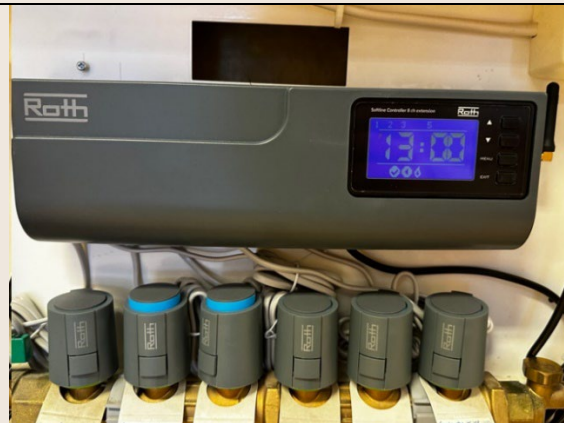
Bilde 8: Gulvvarmestyring, nærbilde. Nyere type fra Roth (Touchline).
