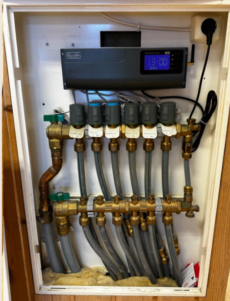
Bilde 7: Gulvvarmeskap (1 av 3) i avdeling. God stand, mulig noe uren væske
