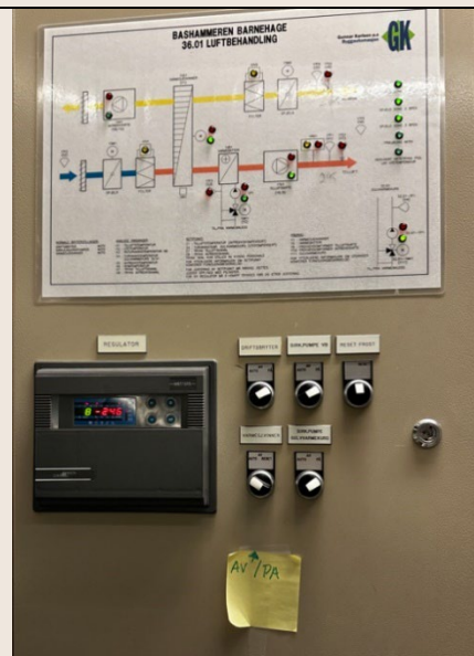
Bilde 12: Styringspanel for ventilasjonsanlegg.
