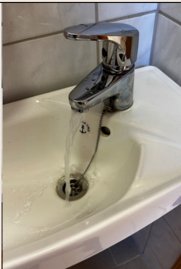
Bilde 3: Armatur med manglende perlator. Noe vedlikeholdsbehov på teknisk installasjon.
