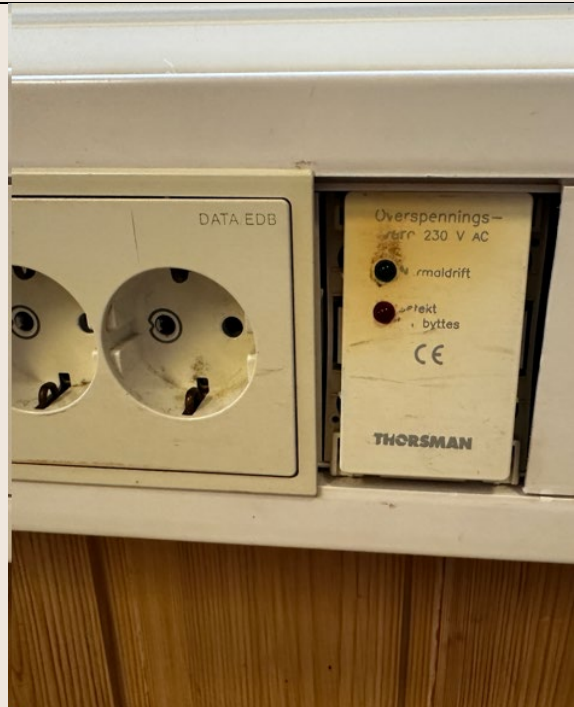
Bilde 2: Overspenningsvern plassert i kabelkanal ute i fellesareal. Trykket inn og mulig feil.
