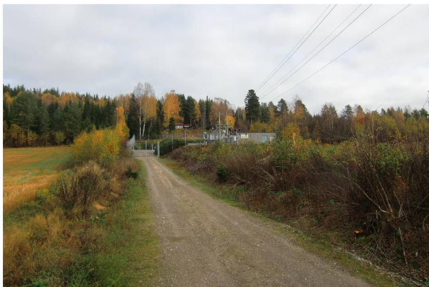
Bildet over viser dagens avkjørsel fra fv. 2088 opp til ELVIA's trafostasjon. Veggen blir oppgradert som del av f_KSV1 og gir atkomst til felt BFS1 med 5 tomter
