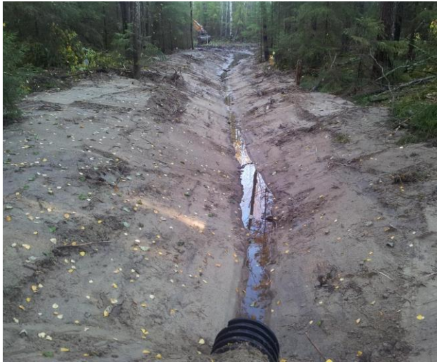
Bilde 4 Flomveg under anlegg
