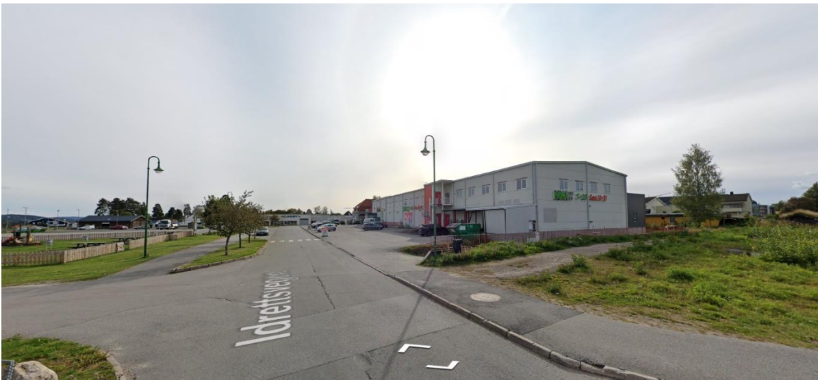
Figur 7 - Gatebilde, planområdet sett fra nordøst i Idrettsvegen
