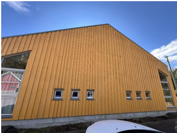
Bilde 1 Tilbygg, bygg N, fra 2000. Kilde: Bilde tatt ved befaring 02.09.2024.
