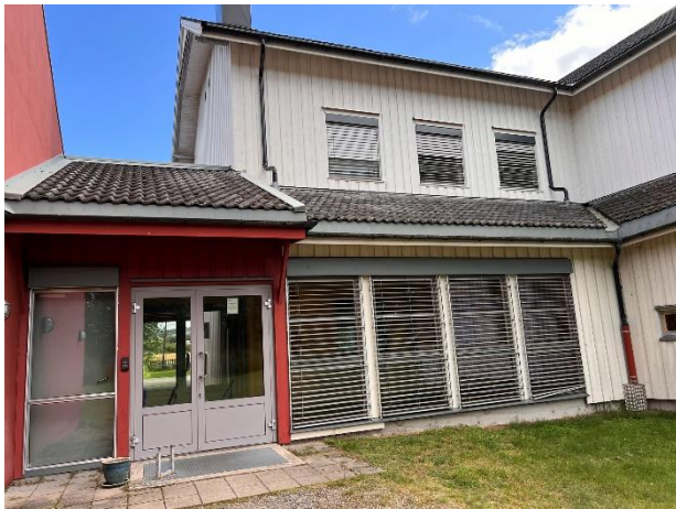
Bilde 7 Overgang mellom bygg N og bygg H. Kilde: Bilde tatt ved befaring 02.09.2024.
