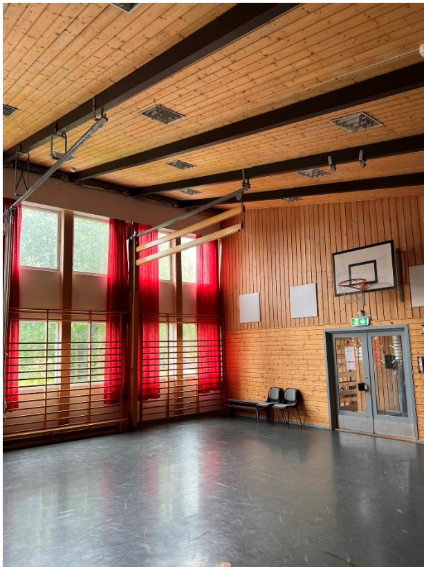
Bilde 9 Innvendig gymsal, bygg G. Kilde: Bilde tatt ved befaring 02.09.2024.
