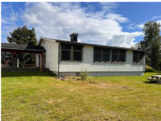
Bilde 5 Bygg A. Utvendig rehabilitert i 2014. Kilde: Bilde tatt ved befaring 02.09.2024.
