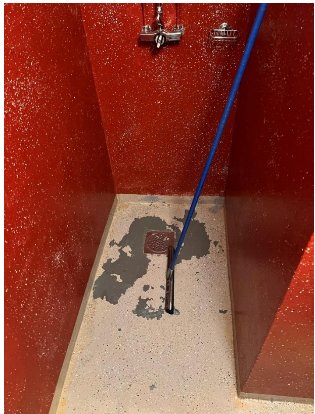
Bilde 14 Dusj ved lærergarderobe i underetasje bygg G. Kilde: Bilde tatt ved befaring 02.09.2024.
