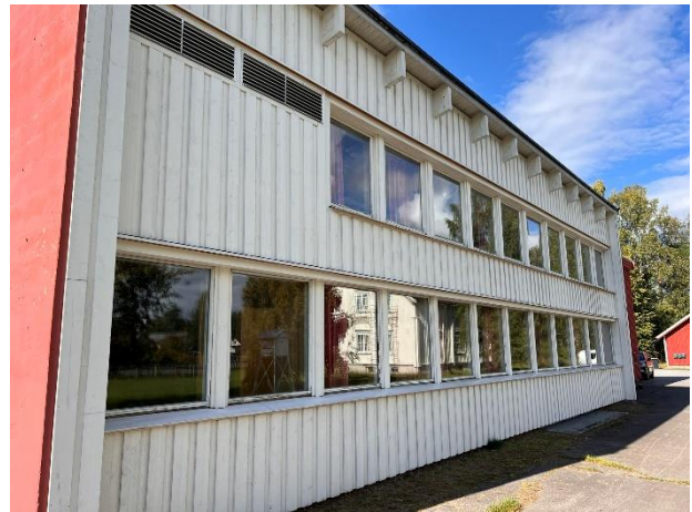
Bilde 8 Bygg G. Vinduer fra 1968. Kilde: Bilde tatt ved befaring 02.09.2024.
