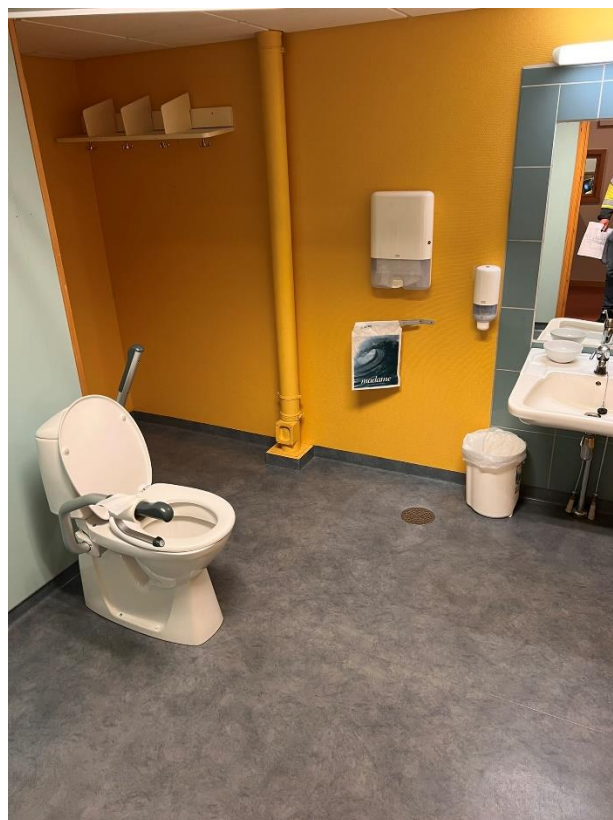
Bilde 16 HC WC bygg N. Kilde: Bilde tatt ved befaring 02.09.2024.
