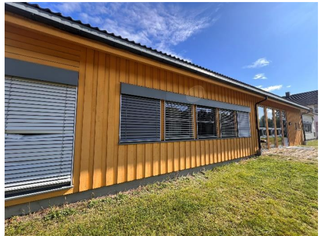
Bilde 2 Tilbygg, bygg N, fra 2000. Kilde: Bilde tatt ved befaring 02.09.2024.
