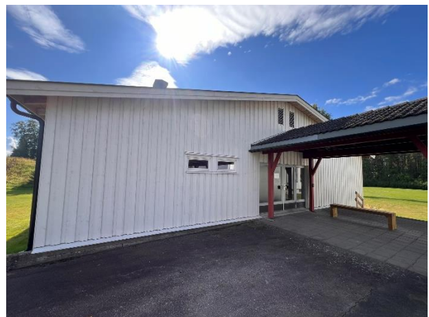
Bilde 6 Bygg A. Utvendig rehabilitert i 2014. Kilde: Bilde tatt ved befaring 02.09.2024.
