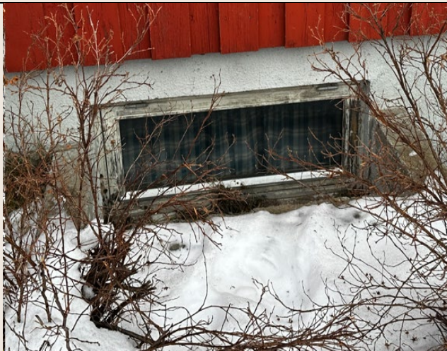
Bilde 7: Eksempel på kjellervindu sett utenfra. Eldre vindu, manglende vedlikeholdt.
