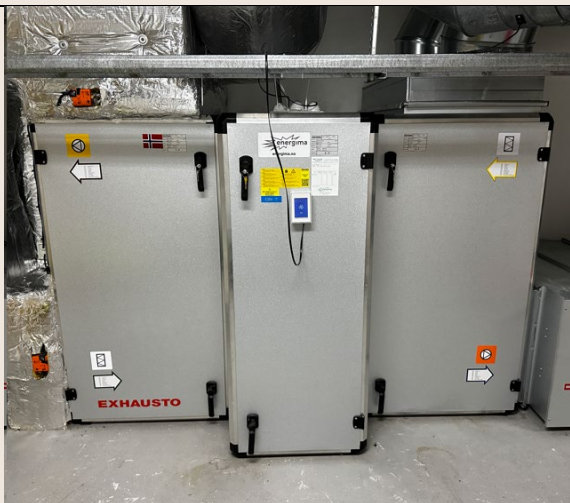
Bilde 3: Ventilasjonsaggregat. Av nyere dato, god stand.
