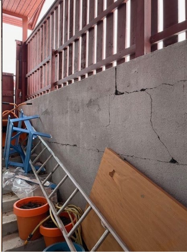
Bilde 1: Støttemur for tak i rømningsvei. Sprekkdannelse langs hele støttemur.
