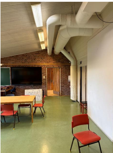
Øvre bygg: Klasserom og ventilasjonsanlegg
