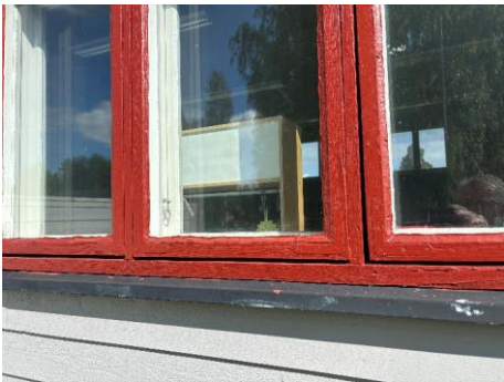
SFO: Opprinnelige vinduer er godt vedlikeholdt og bør bevares videre.
