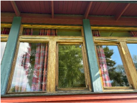
Nedre bygg: Opprinnelig vinduer har gode kvaliteter som bør ivaretas. Enkelte isolerglass byttet 2009.
