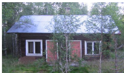
Øvre Posaas-Flisstrand. Liten røykovnsbygning/stue (røykovnen er fjernet), låve og utedo.
