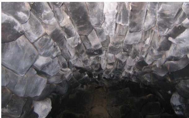
Hvelvet, tørrmurt steintak i en utkjeller.
