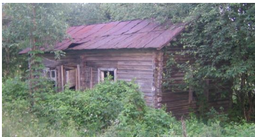
Posåsen, Oppigard, finnetorp/tun. Bygningsmiljø fra første halvdel av 1700-tallet.
