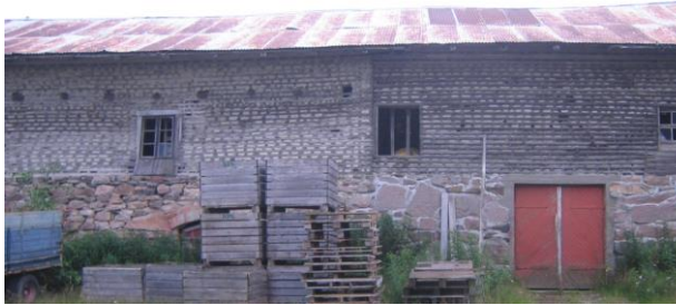
Valbyvelten, låve med kubbefjøs (oppmurt med vedkubber i stedet for murstein).
