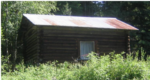
Nedre Høklungen, liten husmannsstue. Bygningsmiljø med stue, bu, løe, låve, sommerfjøs og utedo.
