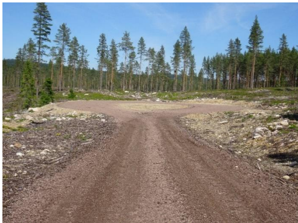
Figur 6 Gode rundkjøringer er viktig på våre vegger. Her fra endesnuplass på ny veg i Haukåsen
