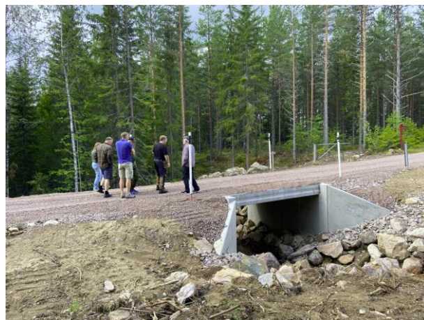
Figur 5: Styret befarer ny bru over Fallbekken i Sørsåsen
