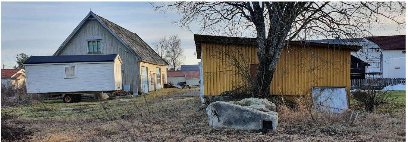
Den tidligere verkstedbygningen på eiendommen til venstre og uthuset/garasjen til høyre på bildet. Sett fra nord. (Bilde Øystein Aurland).
