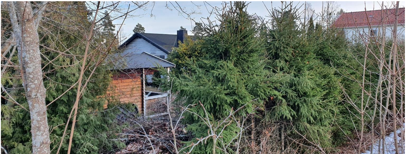
Lekestua og bolighuset på 109/337 sees bak granhekken. Bolighuset på 109/163 i bakgrunnen til høyre. Sett fra nordvest. (Bilde Øystein Aurland).
