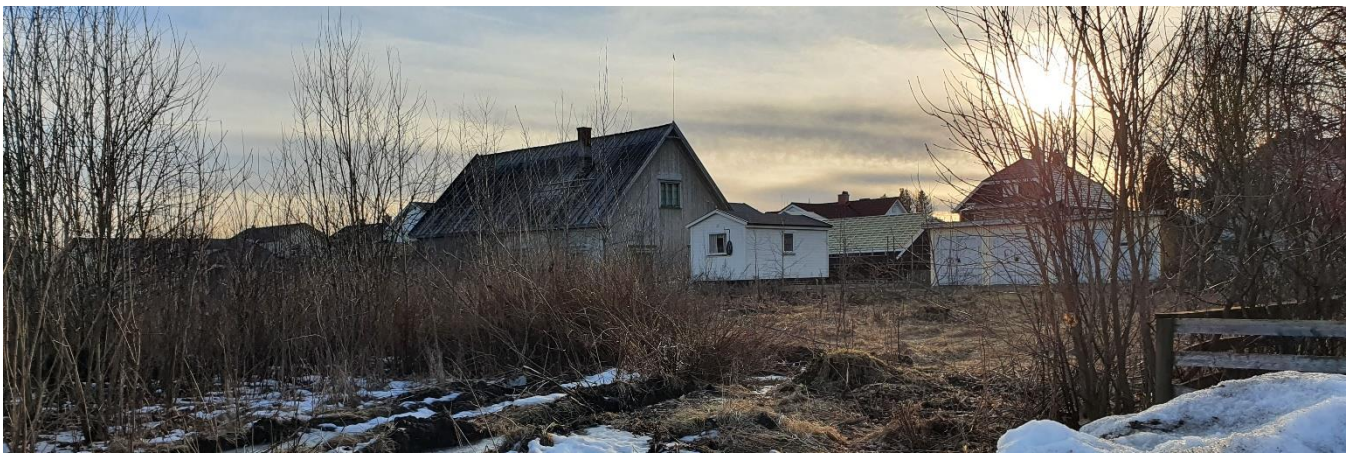
Den tidligere verkstedbygningen til venstre og uthuset/garasjen til høyre på bildet. Det står også en brakke på hjul innen på eiendommen. Sett fra nordøst. (Bilde Øystein Aurland).
